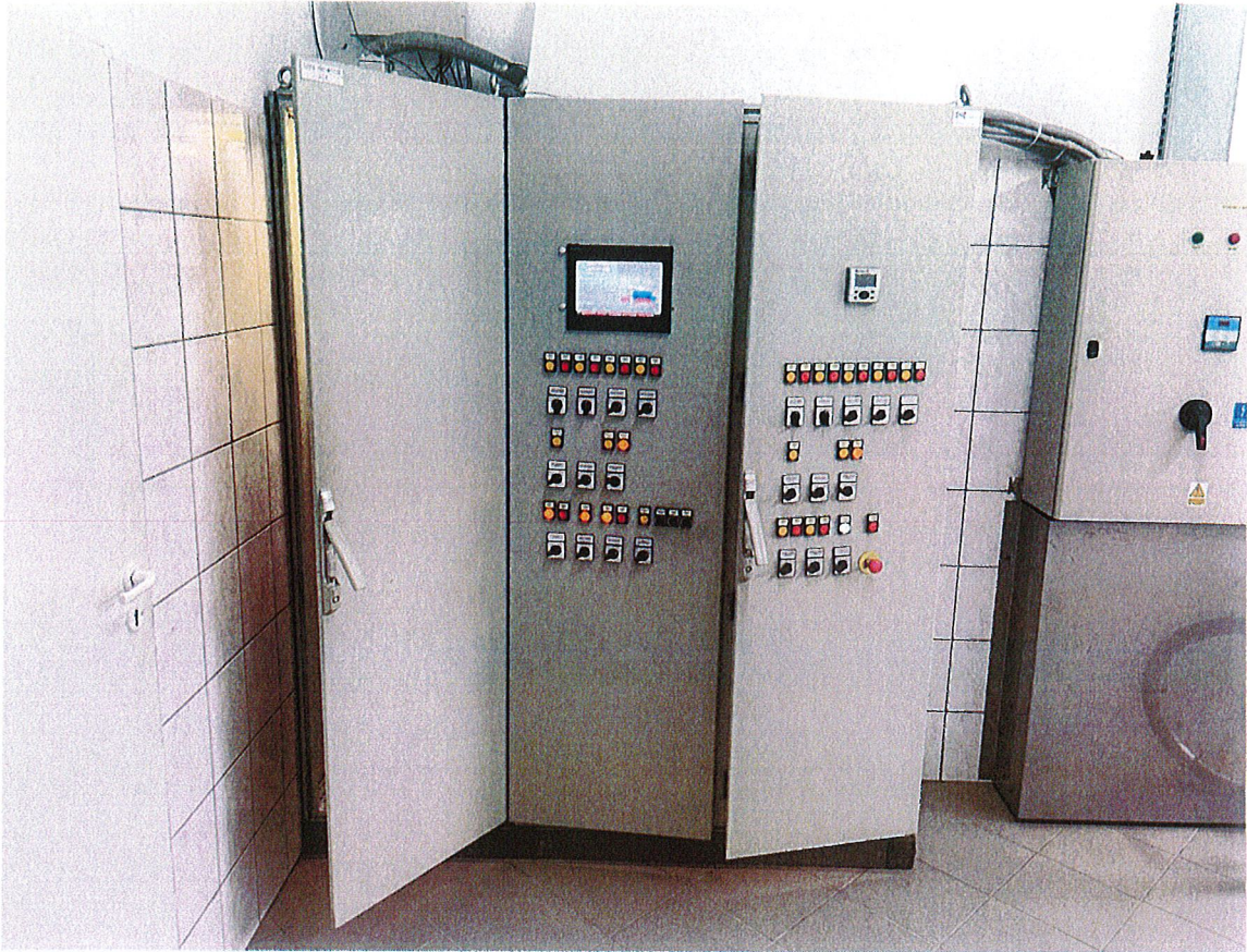
Rys. 8. Zdjęcie przedstawiające istniejące rozdzielnice zasilająco-sterownicze oczyszczalni
