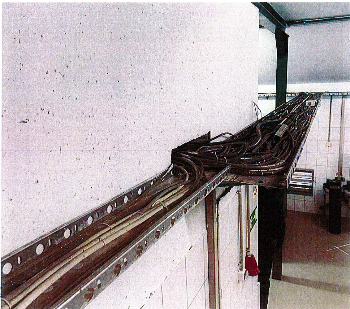
Rys. 9. Zdjęcie przedstawiające wewnętrzne linie zasilająco-sterownicze oczyszczalni
