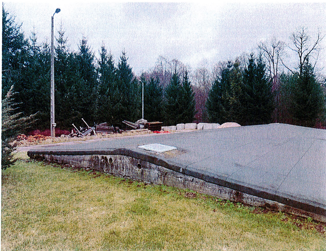
Rys. 5. Zdjęcie przedstawiające komory podziemne oczyszczalni
